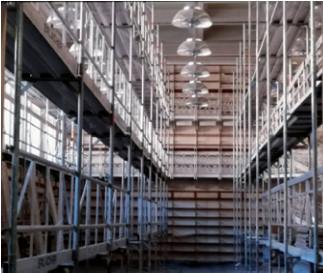
Innenansicht des historischen Lesesaals während der Renovierungsarbeiten
